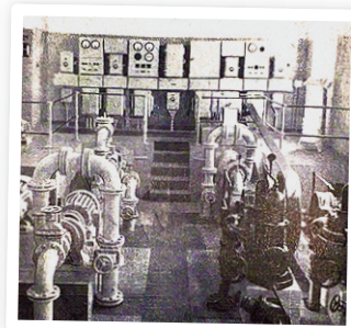
▲ Blick ins neue Wasserwerk, das 1957 in Betrieb ging. ► Historische Unterschriften unterm „Orts-Statut“ zur Wasserversorgung der Stadt.
