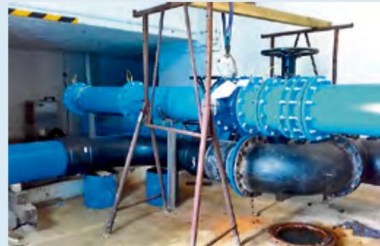
Um Versorgungsunterbrechungen zu vermeiden, wurde ein Provisorium unterhalb der neuen Leitung nachts montiert.
