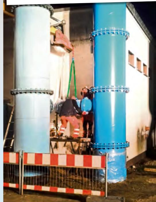
Hier werden die Zuleitungen zum Reinwasserbehälter inkl. des neuen Standrohres (re. im Bild) am Übergabepunkt zur Filterhalle montiert.
