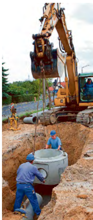
2010 entstand ein weiteres Stück des insgesamt 350km langen WAVE-Abwasserrohrnetzes. Ein Schacht wird eingesetzt.
