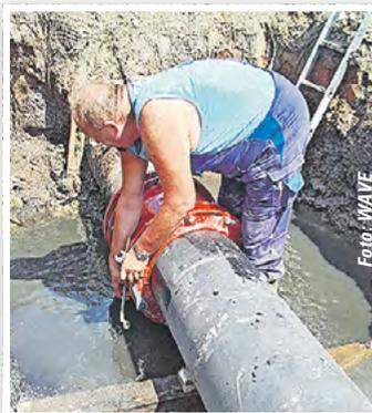
**Eine Rohrkupplung wurde um das neue Rohrteilstück montiert.**
