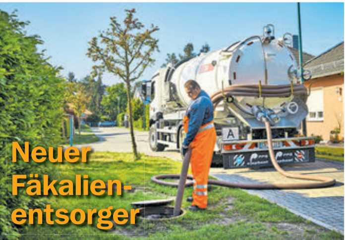
Mit moderner Entsorgungstechnik leeren die Lidzba-Fachleute ab Januar 2020 die Sammelgruben und Kleinkläranlagen. Foto: Lidzba
