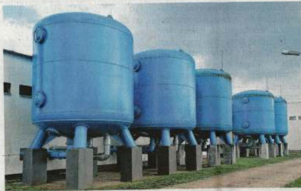
Diese großen Behälter des Wasserwerkes Oschätzchen filtern Mangan und Eisen aus dem Rohwasser heraus.
