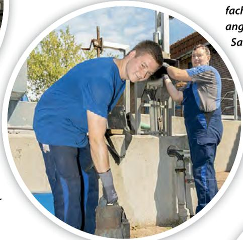
◀ WAVE-Elektriker Felix George (r.) und Abwasserfachkraft Ricci Timm sind auf der Kläranlage angekommen. „Wir müssen die Sandpumpe vom Sandfang wechseln“, meint George. Deshalb bauen beide die Sandsammelschachtpumpe, wie sie korrekt heißt, aus, und Felix George bereitet die Schaltung für die neue Apparatur vor. „Die muss eingestellt und justiert werden, damit die Pumpe den Sand wieder zuverlässig wegfördern kann“, erklärt die Elektrofachkraft.
