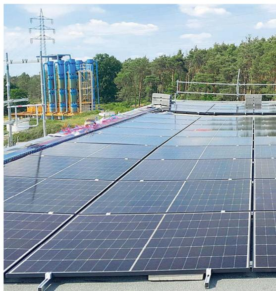
Im vergangenen Jahr wurde das Dach der Filterhalle saniert, damit es die PV-Module tragen kann. Foto: WAVE/Pirschel
