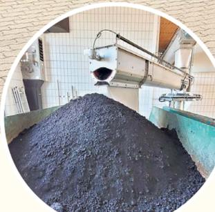
Über die Förderschnecke gelangt entwässertes Klärschlamm in die Container.
