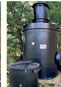
Foto rechts: Biofilter und Dosierstation sollen bereits hier einen Großteil der Faulgerüche eliminieren.
