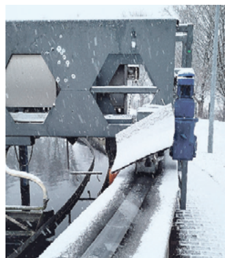
Ohne Heizung besteht die Gefahr, dass die Räumernbrücke im Winter an der Beckenkronen festfriert.
